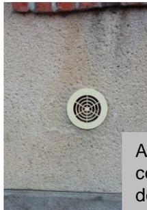
Amenée d'air en façade condamnée à l'intérieur par un doublage de plaques de plâtre
