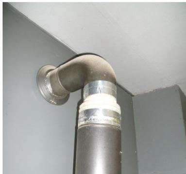
Conduit de raccordement d'un poêle à bois non conforme (section conduit < section sortie poêle)
