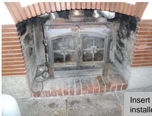
Insert vétuste, non entretenu, installé par un particulier
