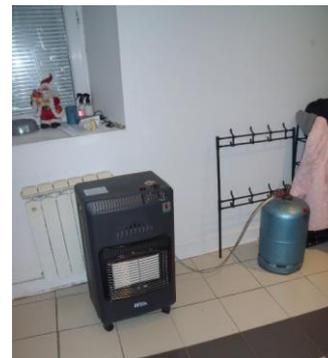
Utilisation d'un poêle à gaz dans un logement non ventilé
